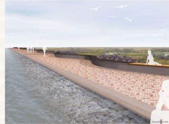
Mit der Neugestaltung verwandelt sich die Promenade in einen 'Strand' - bilden schlagen an Land, hinterlassen Sediment, Muscheln, forsen die Mauer. Die geschwungene Küstenschutzmauer nimmt die Energie des Wassers auf und leitet die Wellen.
